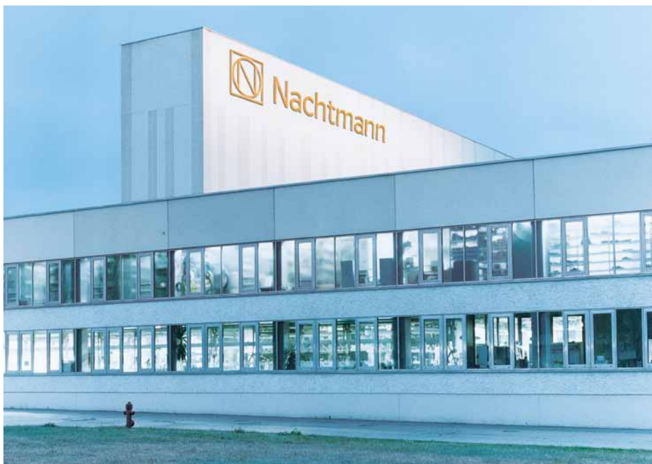
Das Nachtmann-Firmengebäude mit Hochregallager am Standort Weiden. Die Firmenzentrale befindet sich in Neustadt an der Waldnaab, wo das Traditionsunternehmen seit 1900 residiert.
